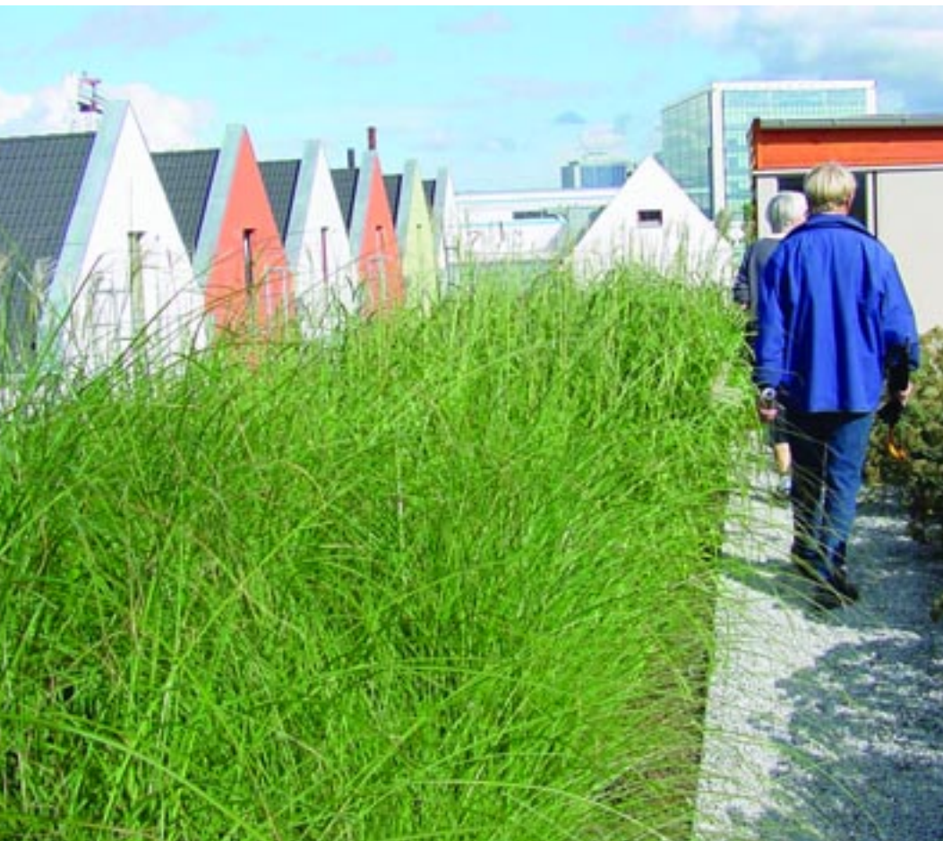
Beloopbaar grasdak in Malmö
